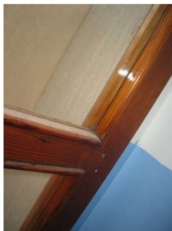
Figura 5 - Dettaglio di un serramento in legno e vetro singolo
